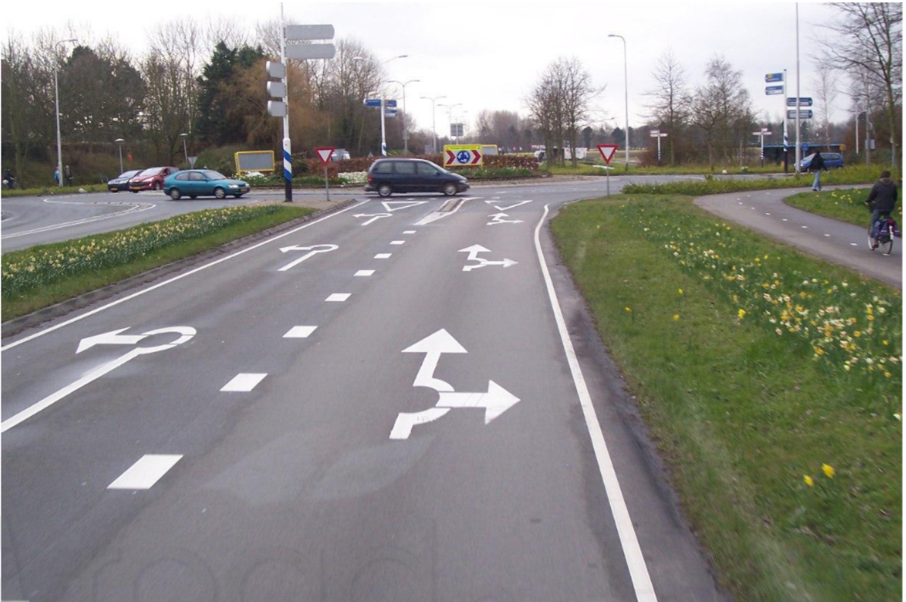
Рисунок Б.6 — Каналізування потоків
