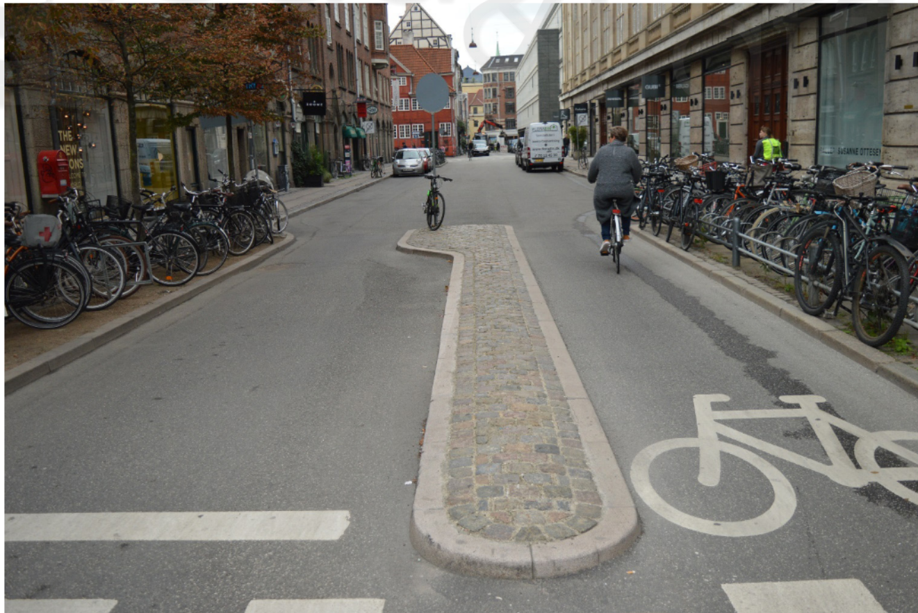
Рисунок Б.9 — Вставки по осі дороги
